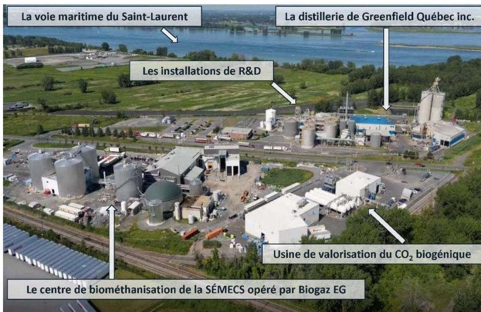
D'une capacité de production de 190 millions de litres par année (MLPA), notre distillerie de Varennes est en opération continue depuis 2007. Elle est actuellement la seule à produire de l'éthanol de grade carburant à faible indice carbone (IC) au Québec. Notre distillerie ne produit aucun rejet; les différents co-produits générés par notre procédé sont valorisés localement dans une optique d'économie verte circulaire :
