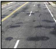
❖ Une **dégradation de la surface** augmente les infiltrations d'eau et accélère la dégradation de la structure de rue.
